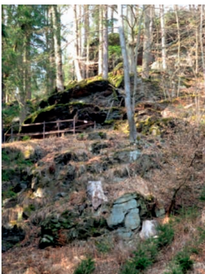
Obr. 2. Úklonná šachta Cumberk je situována až ve vrcholové části jižního svahu Zásčalského potoka, vstup do úklonné šachty ze shora je chráněn mříží (foto L. Stránský 2012)
