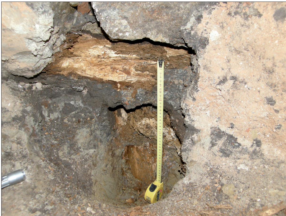
Obr. 8: Základový dubový rošt a borová pilota v sondě 1 (foto 21. 4. 2009)
