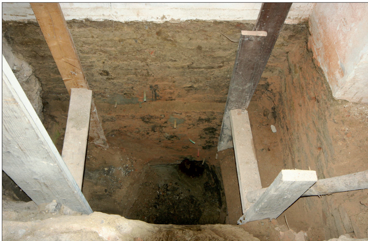
Obr. 7: Pohled do vykopané sondy č. 1 s viditelnou základovou spárkou v hloubce 2,2 m pod úroveň podlahy (foto 1. 7. 2009)
