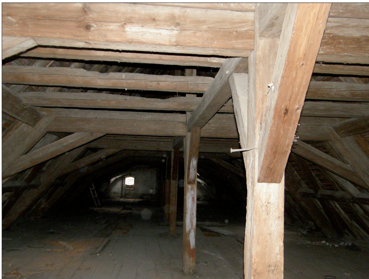
Obr. 11: Konstrukce krovu – ležatá stolice (v Ránkové úpravě)
