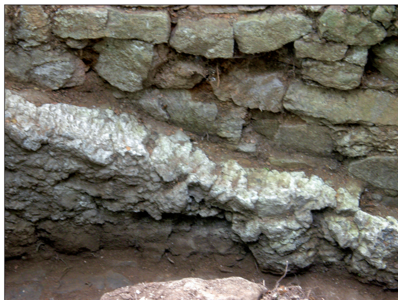
Obr. 7: Čelesno (opora pro zaklenutí roštu)
