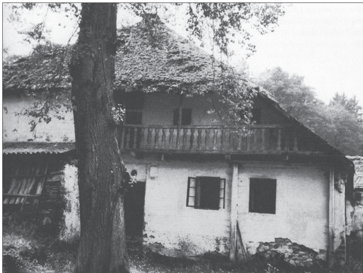
Obr. 4: Hoslovice, mlýn zmíněný v r. 1352, stav před opravou (foto L. Štěpán, 2007)
