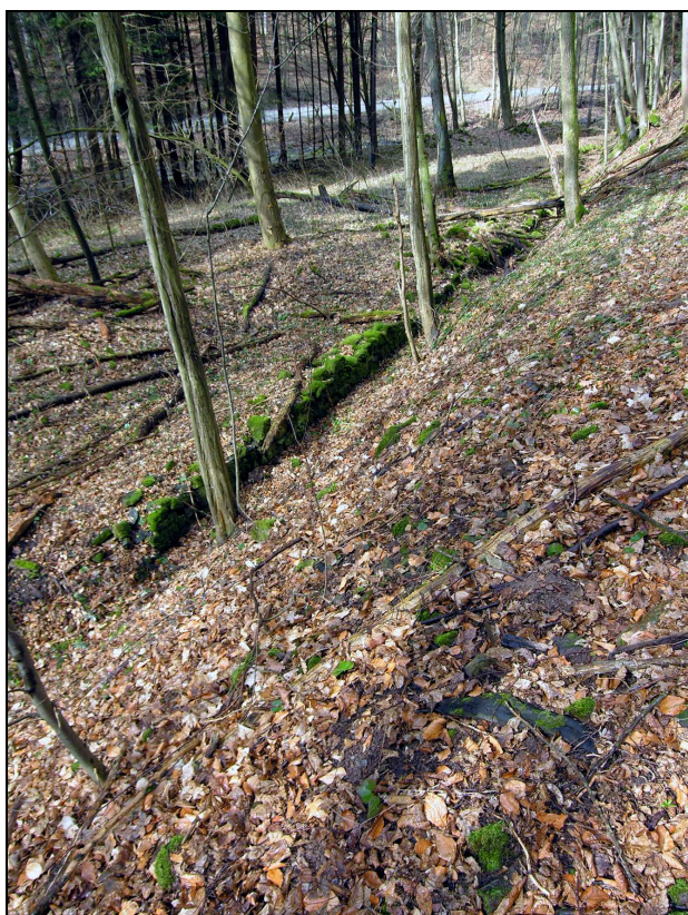
Obr. 4 Část vyzděného náhonu, pohled směrem k jezu, stav 2009
