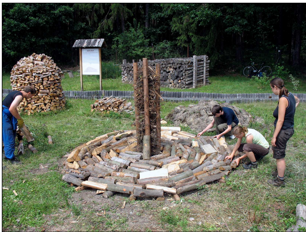
Obr. 2 Na roštu je položena izolační dřevěná podlaha
