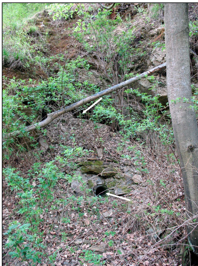
Obr. 6 Zasutá horní štola – číslo 1 v údolí potoka Stříbrnice. Šipkami je znázorněno otevření – nahoře a odvodnění – dole
