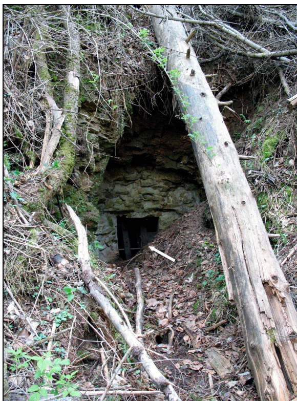
Obr. 8 Zazděná dolní štola – číslo 3 v údolí potoka Stříbrnice. Šipka znázorňuje mříže ve vyzděném spodním otvoru štoly
