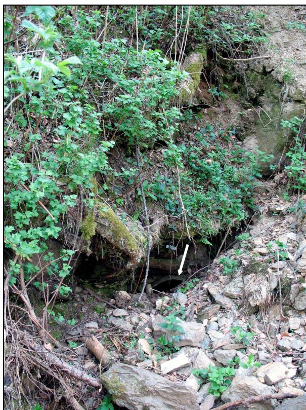
Obr. 7 Zasutá prostřední štola – číslo 2 v údolí potoka Stříbrnice. Šipkou je označeno odvodnění
