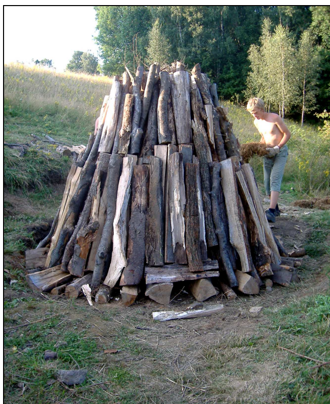
Obr. 6 Uhřínov pod Deštnou v Orlických horách, stavba milíře
