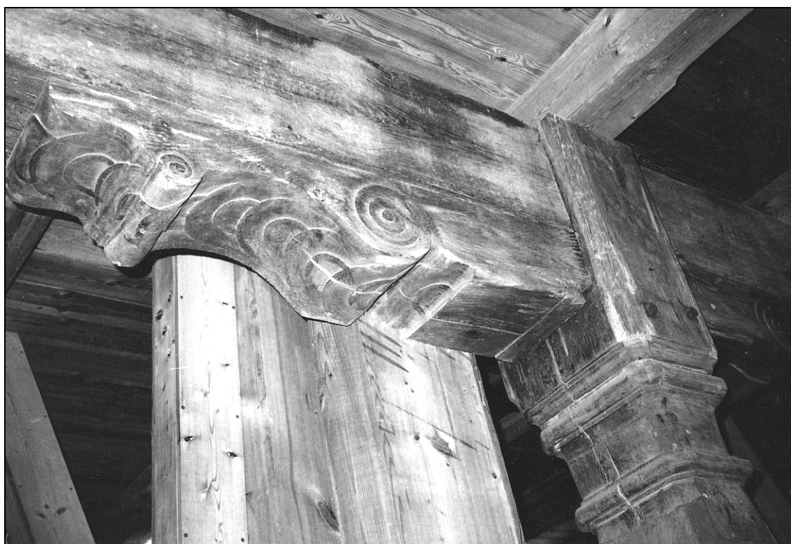
Obr. 10 Detail zdobené hlavice sloupové podpory se sedlem a průvlakem v podkolí (foto TMB)
