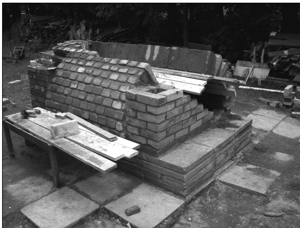
Obr. 16 Experimentální výroba potaše – stavba kalcinační pece. Deštné v Orlických horách (foto J. Woitsch, 2004)
