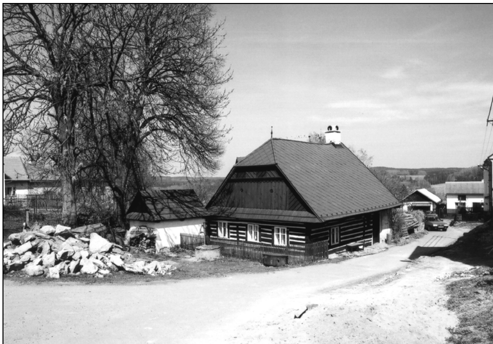
Obr. 19 Pohled na stavení čp. 47 v Dřevíkově (okr. Chrudim). Vlevo od domu bývalá draslárna (foto J. Woitsch, 2003)
