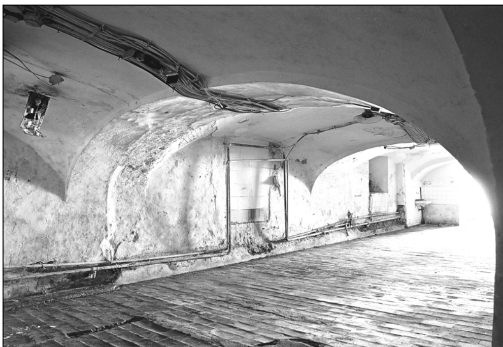
Obr. 7 Pohled do prostor prvního podzemního podlaží bývalé sýpky
