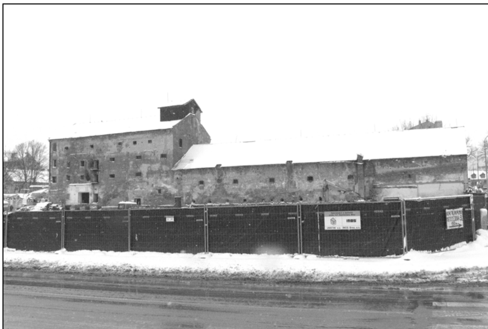
Obr. 6 Celkový pohled na budovy bývalého pivovaru po zbourání uličního křídla.
