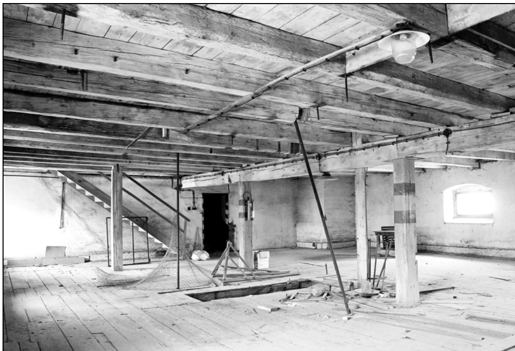
Obr. 8 Interiér druhého nadzemního podlaží bývalé sladovny
