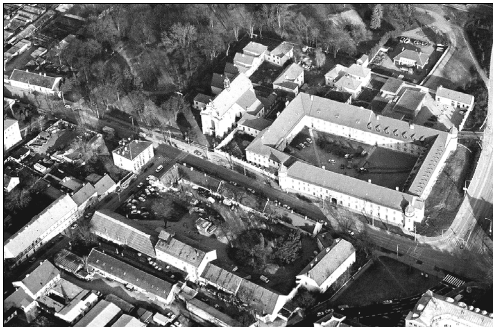
Obr. 2 Letecký záběr na areál bývalého kartuziánského kláštera v Králově Polí s hospodářským dvorem – pohled od jihozápadu (Foto M. Bálek)
