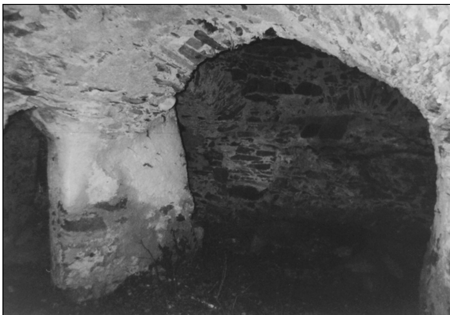
Obr. 4 Zadná klenba vysokej pece so zadnou stenou výmurovky
