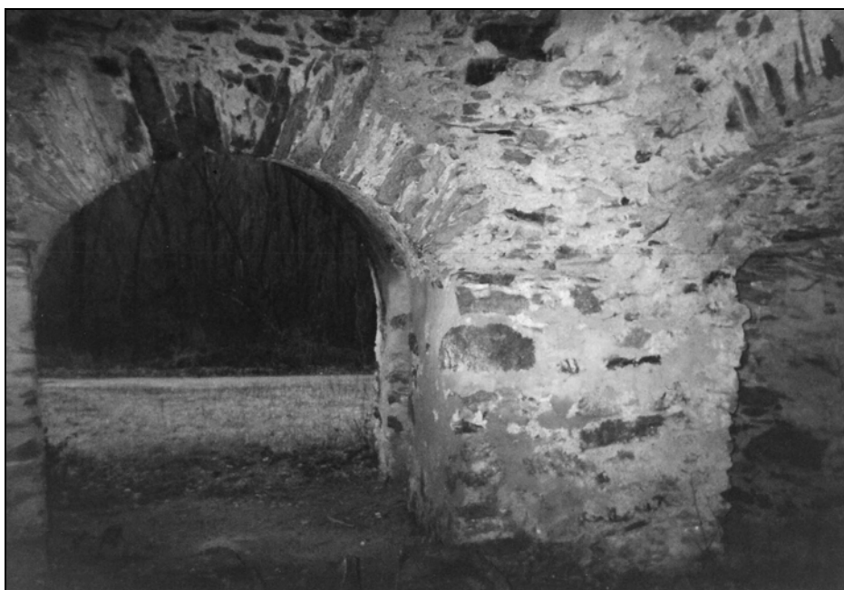
Obr. 3 Bočná klenba vysokej pece
