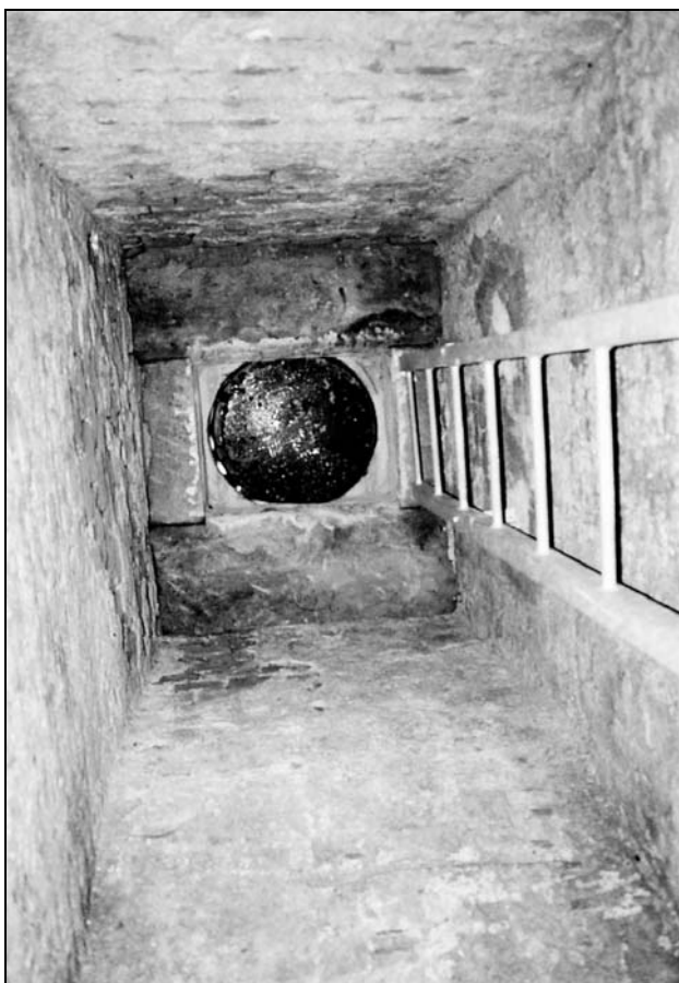
Obr. 7 Pohled do kontrolní šachty ústící do parku
